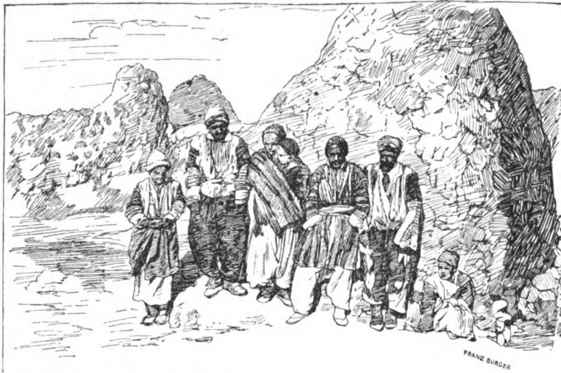
Unsere Erdarbeiter in Karakhan.
