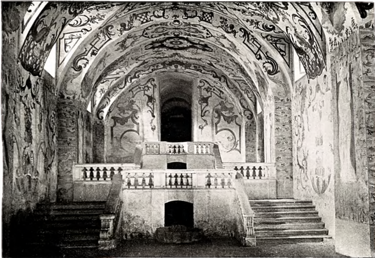
Fig. 355 Altenburg, Stift, Krypta mit Treppenanlage (S. 316)
