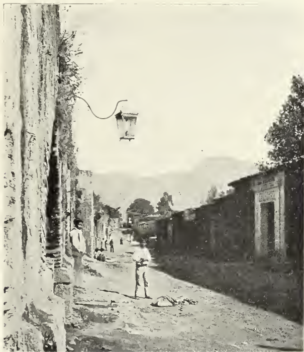
Vorstadtstrasse bei der Wasserleitung
