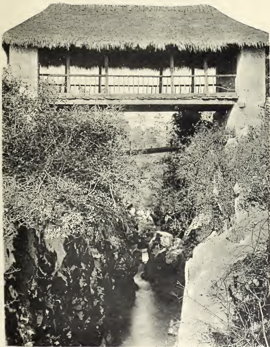
Brücke bei El Verjel
