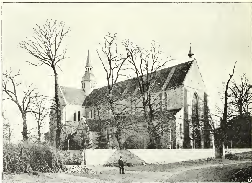
47. Riddagshausen, nordwestliche Ansicht der Klosterkirche.
